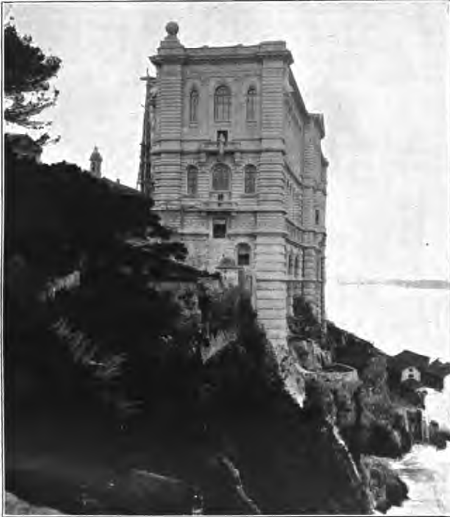
A. END FAÇADE.
